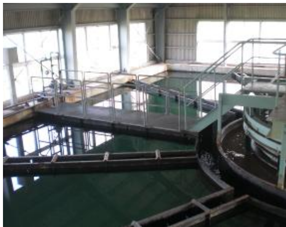
■道金浄水場 高速凝集沈殿池
