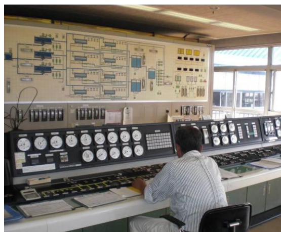
■道金浄水場 監視制御室
