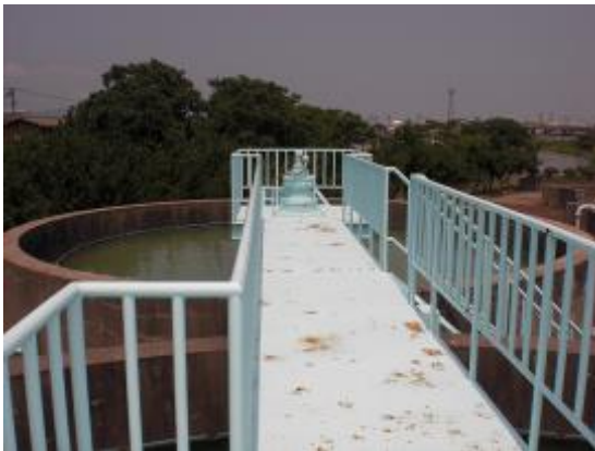
■吉田浄水場 汚泥濃縮槽
