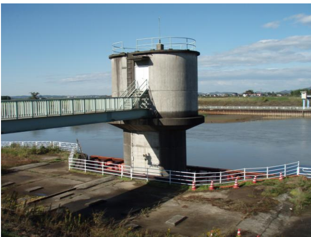
■ 道金浄水場 取水塔
