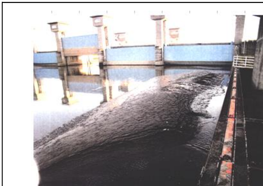
道金浄水場取水塔付近状況 H19 10月 水門特例操作 川底に泥堆積
