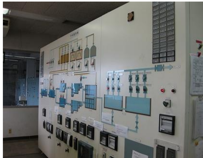
分水浄水場 耐用年数を過ぎた監視施設
