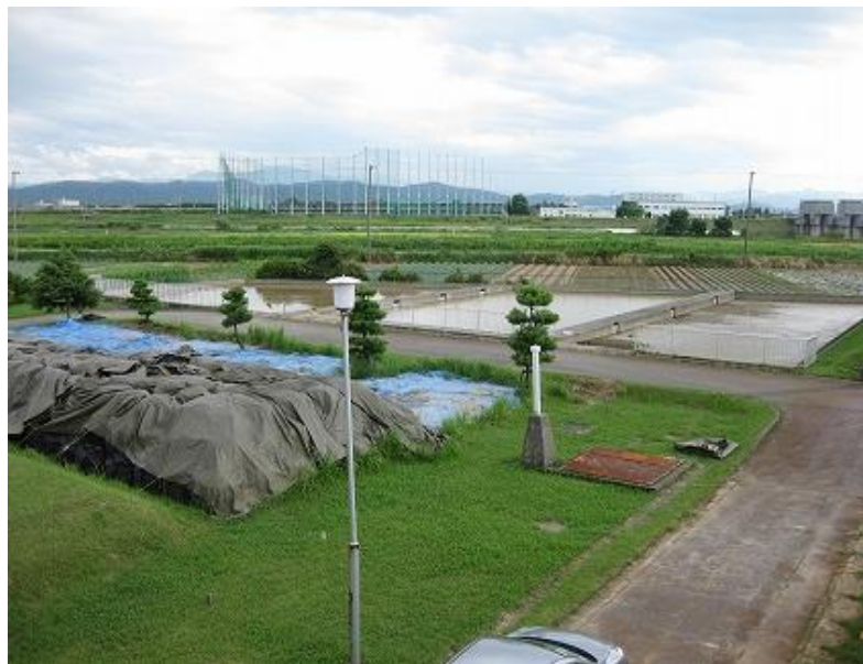
道金浄水場 河川の原水濁度上昇のため常時満杯な天日乾燥床
