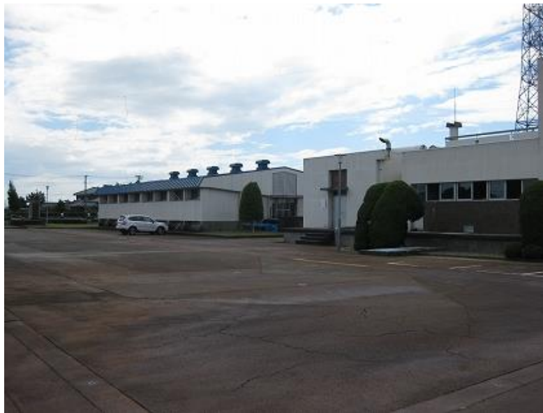
吉田浄水場 急速ろ過池、管理棟 耐震性の低い構造物
