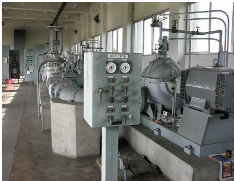
道金浄水場 配水ポンプが老朽化 交換部品が製造中止
