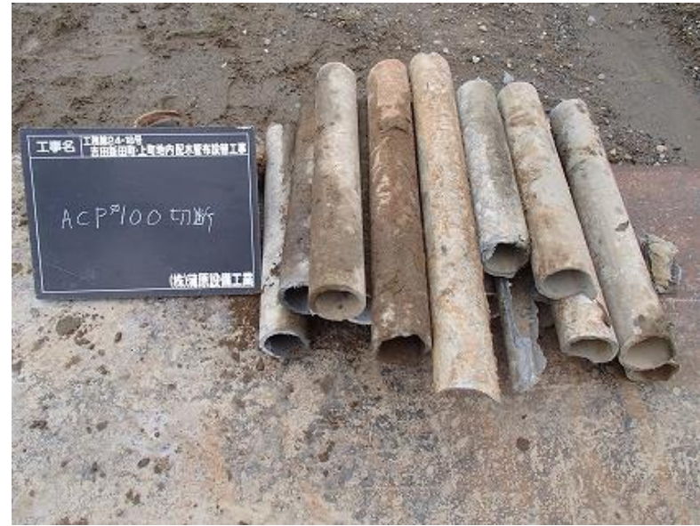
老朽石綿管 老朽化でもろく変化し配水圧力を上げられない配水管が多く残る
