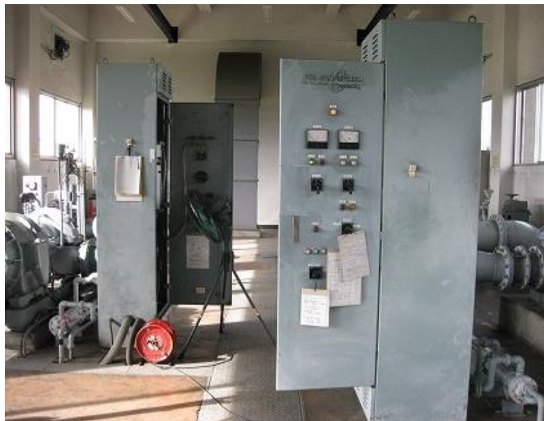
道金浄水場 回転数制御装置が老朽化 年中空冷で持たせている
