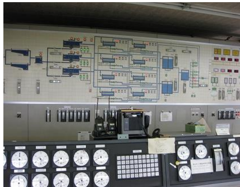
道金浄水場 耐用年数を過ぎた監視施設
