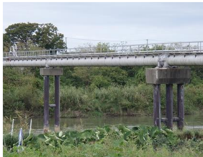
道金浄水場 φ900配水幹線水管橋 市内に向けた唯一の幹線だが、橋脚が老朽化
