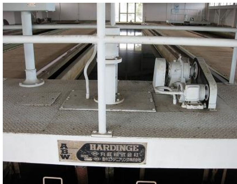
吉田浄水場 急速ろ過池 ろ過洗浄装置が老朽化
