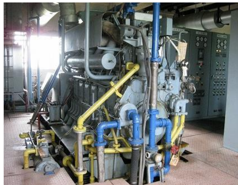
道金浄水場 自家発電室 旧型で老朽化が進む
