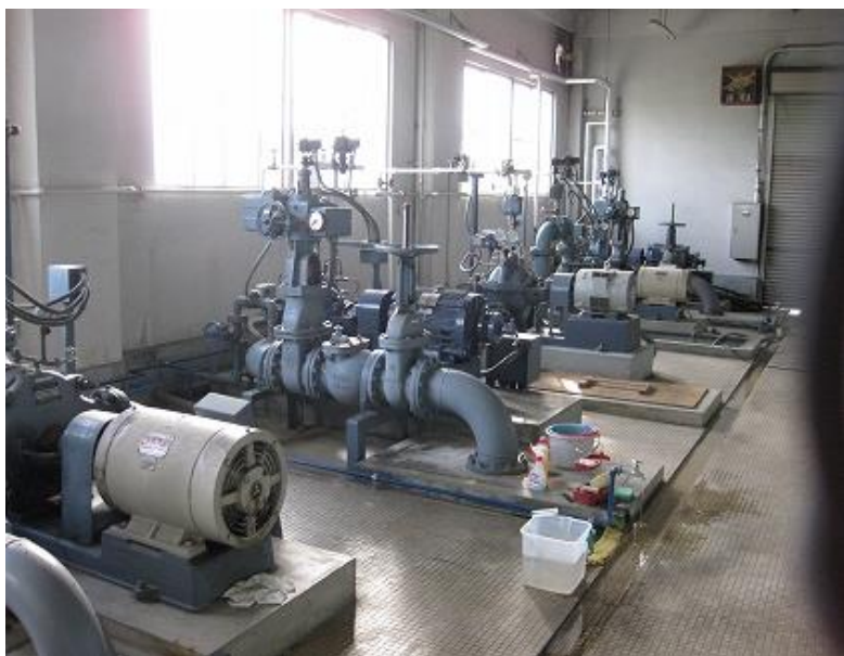
分水浄水場 耐用年数を過ぎたポンプ施設
