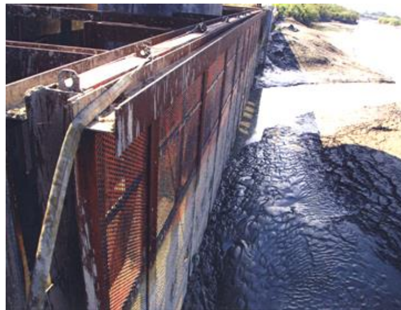
道金浄水場取水塔付近状況 H19 10月 水門特例操作 川底に泥堆積
