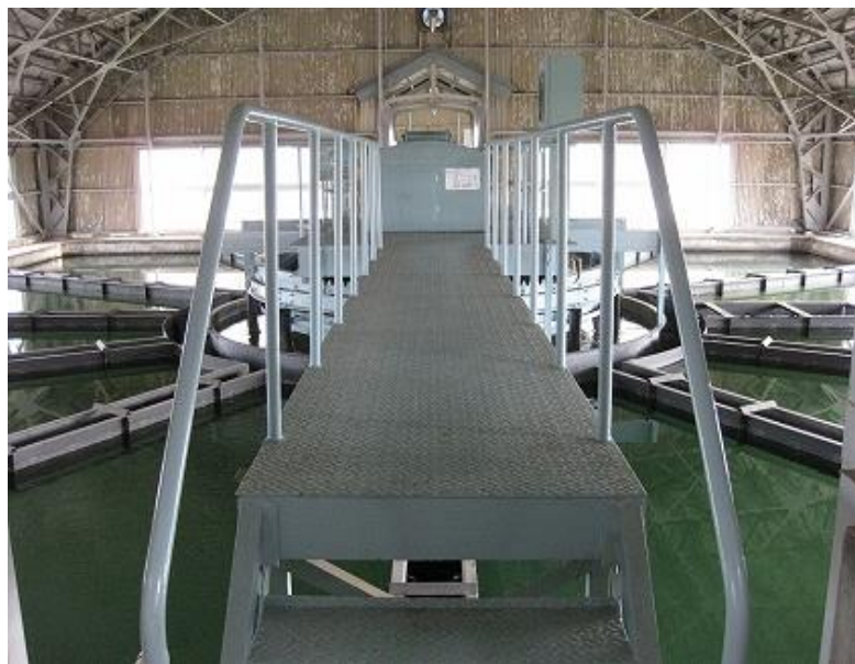
道金浄水場 高速沈でん池 高濁時沈でん処理が困難
