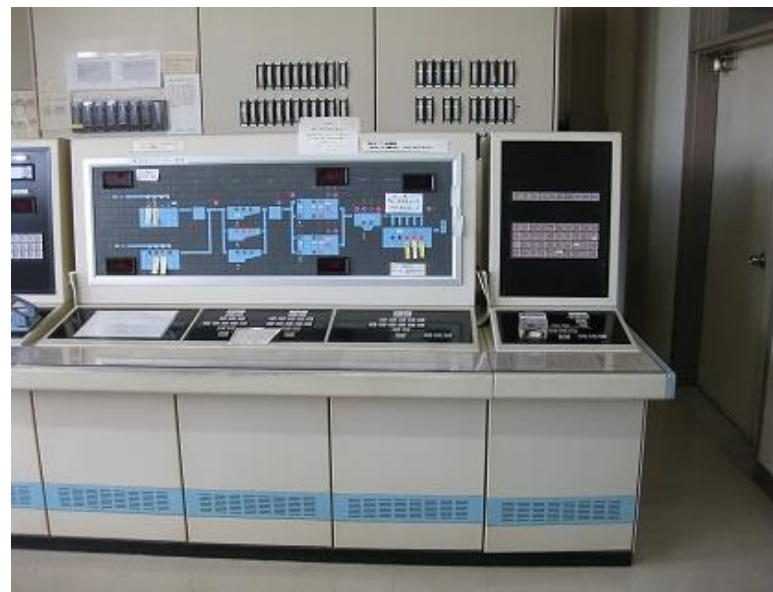
吉田浄水場 耐用年数を過ぎた監視施設
