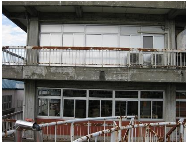
道金浄水場 耐震性の低い構造物
