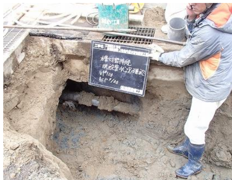
老朽管布設替工事 既設石綿管と塩ビ管接続箇所
