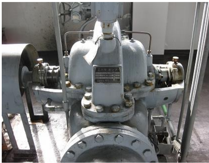
道金浄水場・吉田浄水場・分水浄水場共 配水ポンプが老朽化し、交換部品が製造中止となっている。
