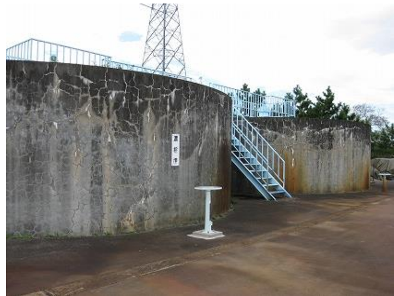
吉田浄水場 濃縮槽老朽化、亀裂入る
