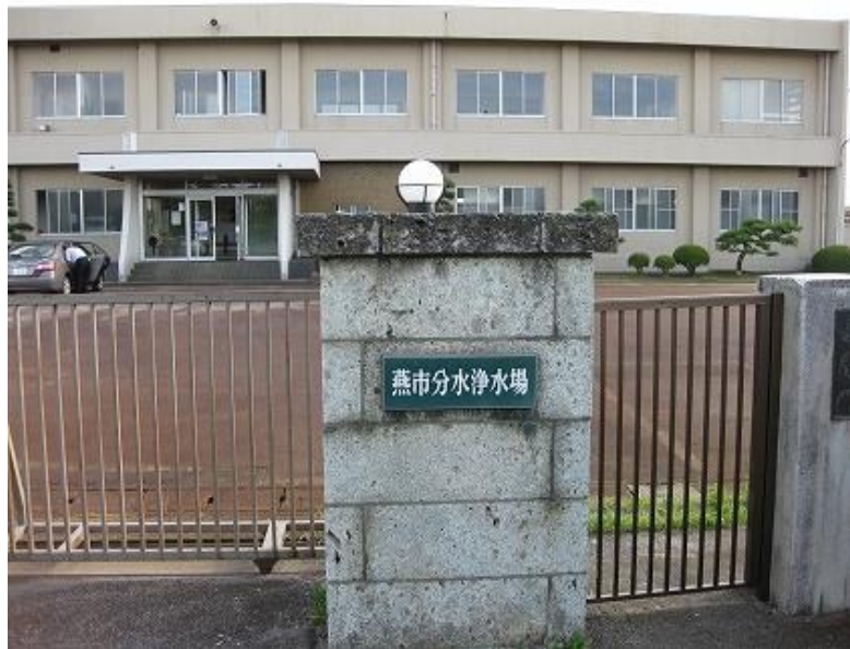
分水浄水場 耐震性の低い構造物
