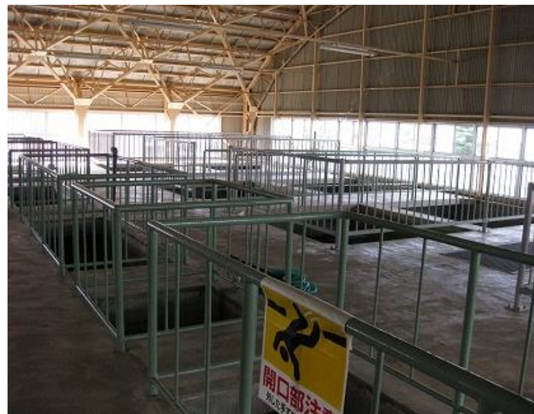
道金浄水場 急速ろ過池 池内配管(鋼管)の腐食が進んでいる
