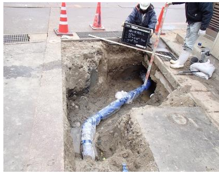
老朽管布設替工事 石綿セメント管・経年管が多く残り、耐震管にて布設替を進めている。
