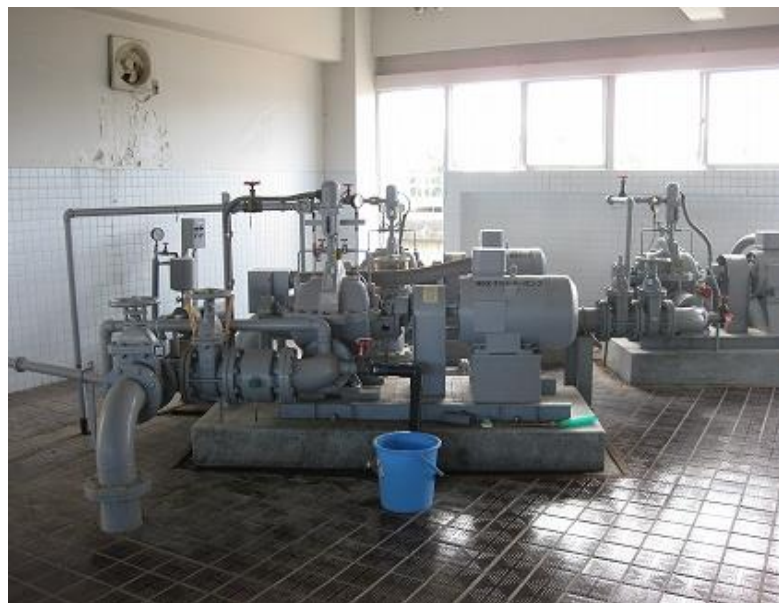
吉田浄水場 耐用年数を過ぎたポンプ施設
