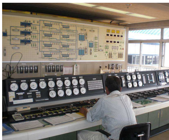
■道金浄水場 監視制御室
