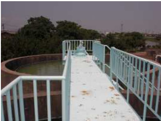
■吉田浄水場 汚泥濃縮槽
