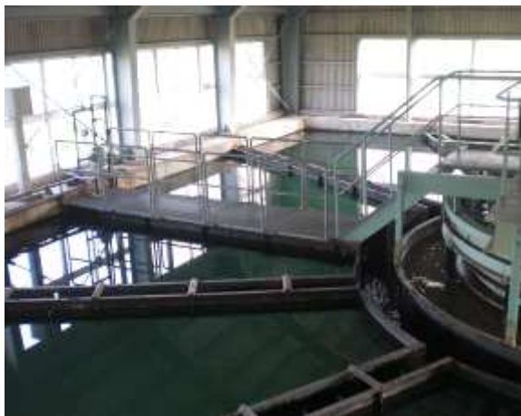
■道金浄水場 高速凝集沈殿池
