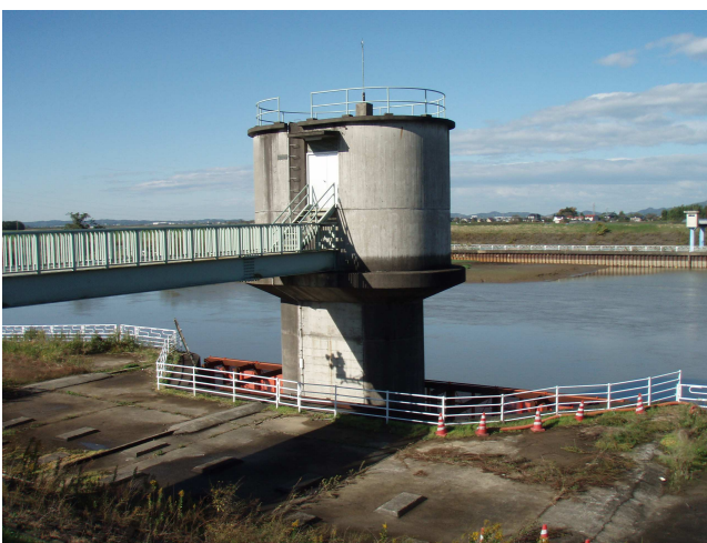
■ 道金浄水場 取水塔
