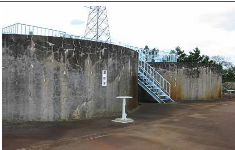
濃縮槽(吉田浄水場)
