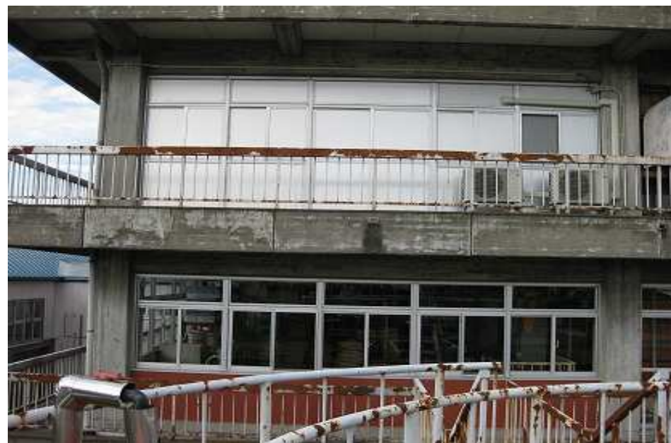
道金浄水場：耐震性の低い構造体
