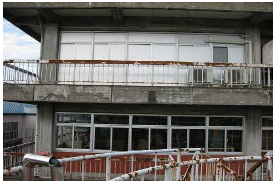
道金浄水場:耐震性の低い構造体
