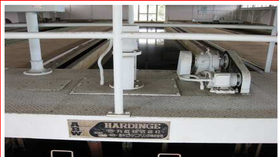
急速ろ過池のろ過洗浄装置(吉田浄水場)
