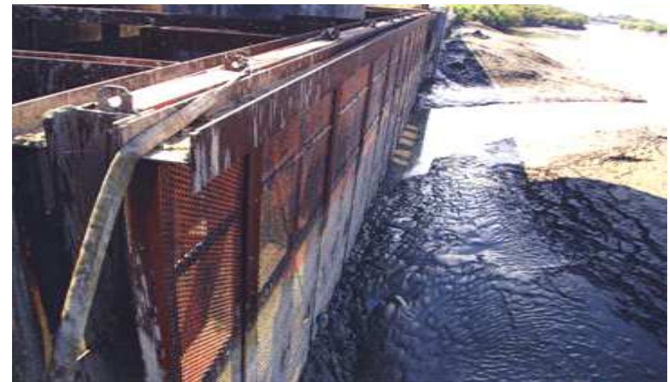
道金浄水場取水塔付近：川底に泥が堆積し取水が困難な状況
