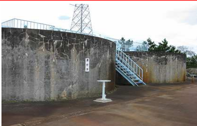
濃縮槽(吉田浄水場)
