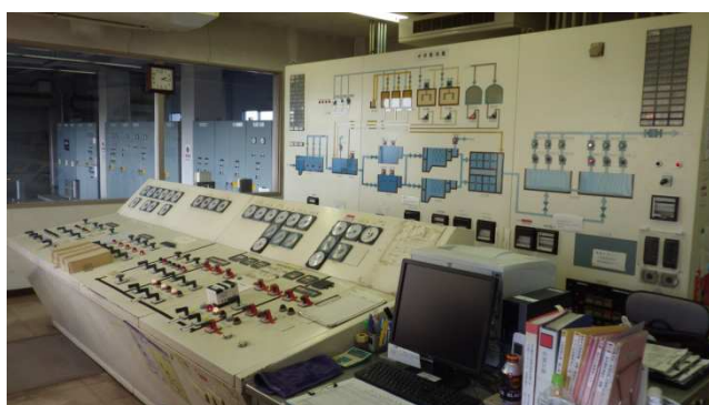
分水浄水場 中央操作盤
