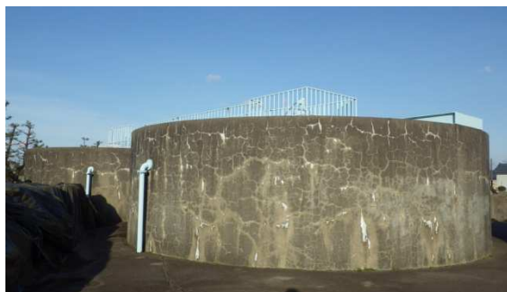
吉田浄水場 濃縮槽
