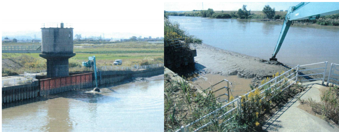
図 2.5 浚渫の様子（道金浄水場取水位置）
