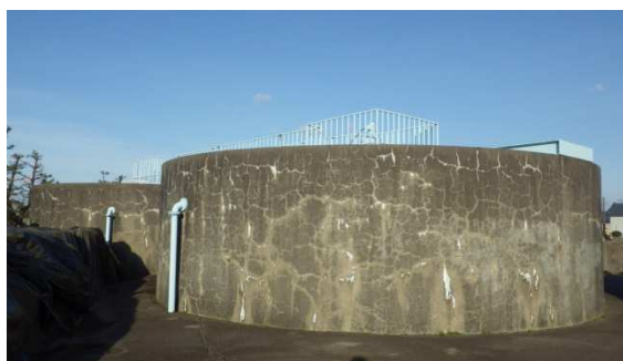
吉田浄水場 濃縮槽
