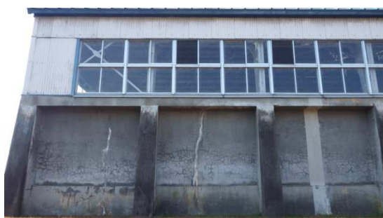
道金浄水場 高速凝集沈殿池
