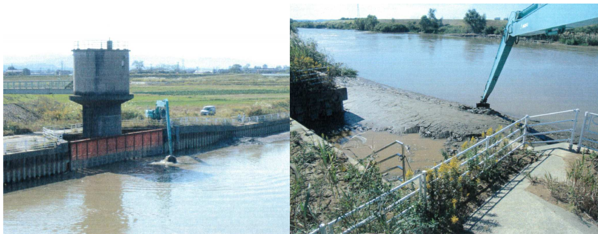
図 2.5 浚渫の様子（道金浄水場取水位置）
