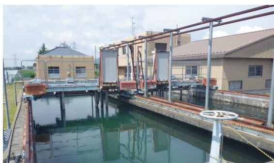
弥彦浄水場 第 2 沈澱池
