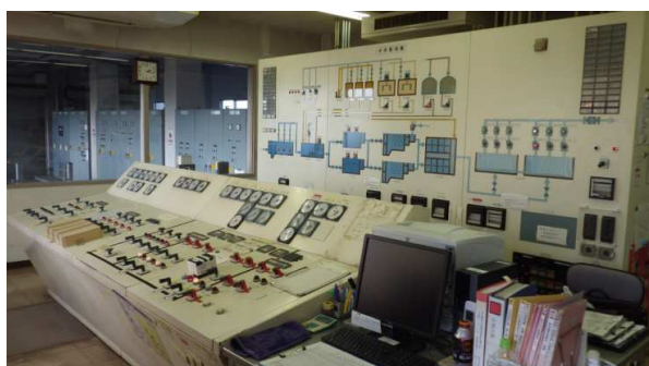
分水浄水場 中央操作盤
