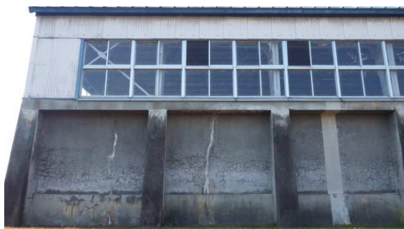
道金浄水場 高速凝集沈殿池
