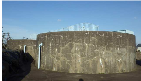
吉田浄水場 濃縮槽
