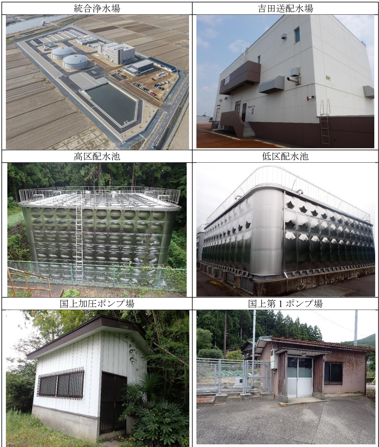
図 7-2 水道施設の現状
