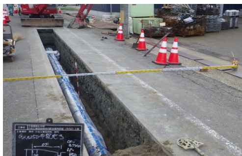
【配水管（耐震管）布設状況】
