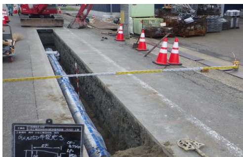
【配水管（耐震管）布設状況】
