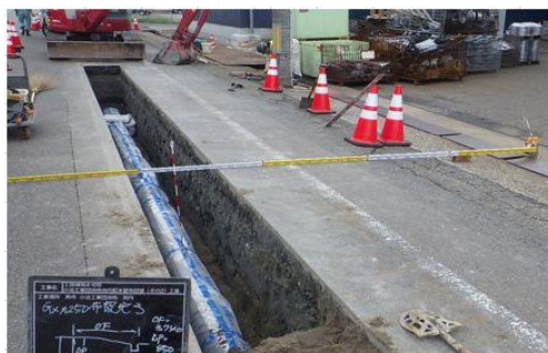
【配水管（耐震管）布設状況】
