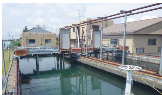
弥彦浄水場 第 2 沈澱池
