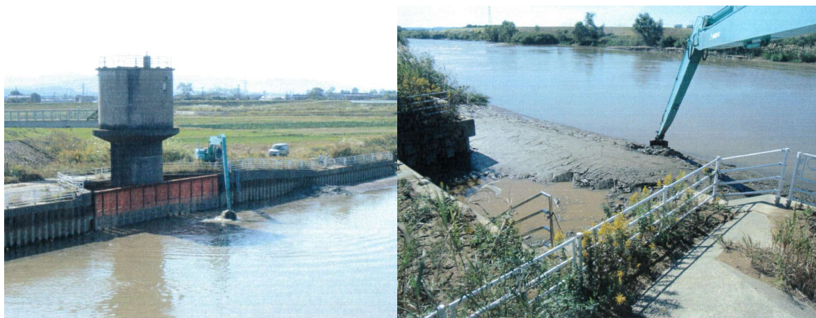
図 2.5 浚渫の様子（道金浄水場取水位置）
