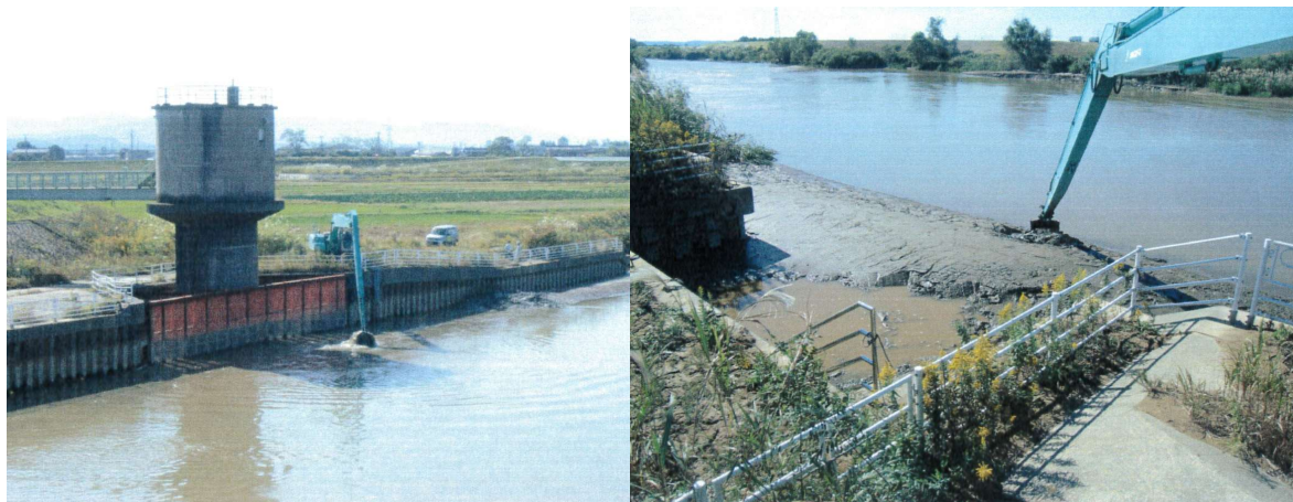
図 2.5 浚渫の様子（道金浄水場取水位置）
