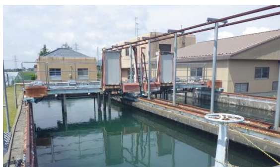
弥彦浄水場 第 2 沈澱池
