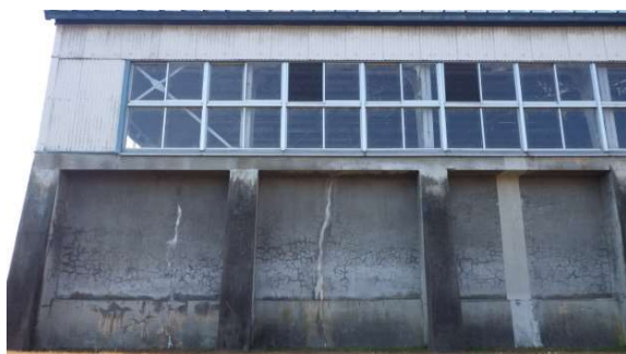
道金浄水場 高速凝集沈殿池
