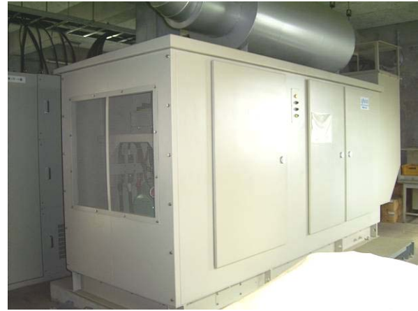
非常用発電機
