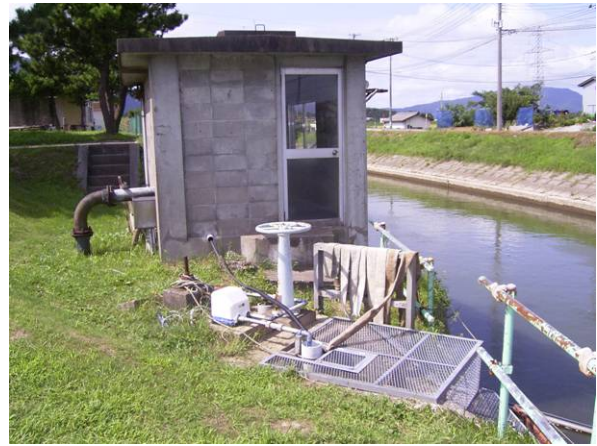
西川取水口近景
