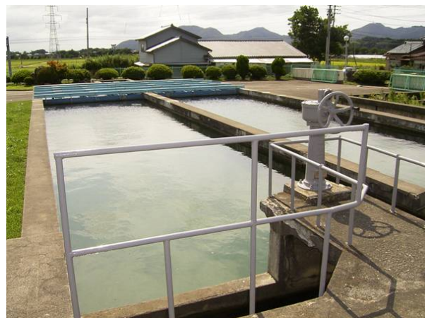
第1薬品沈殿池近景
