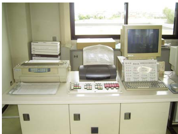
監視室計装機器
