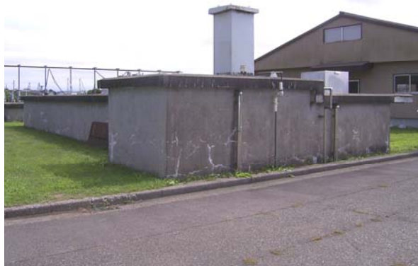
着水井フロック形成池全景
