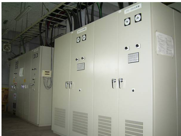
電気室内部計装盤
