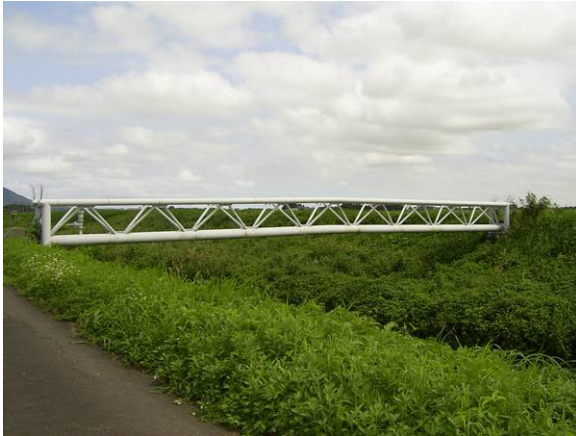
矢川水管橋全景
