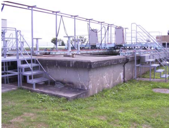
第2薬品沈殿池全景
