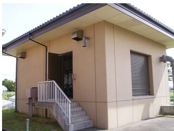
送水ポンプ室全景
