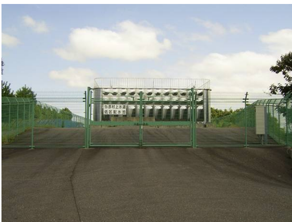
低区ステンレス配水池正面
