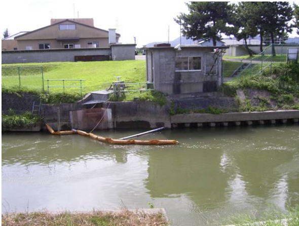
西川取水口全景
