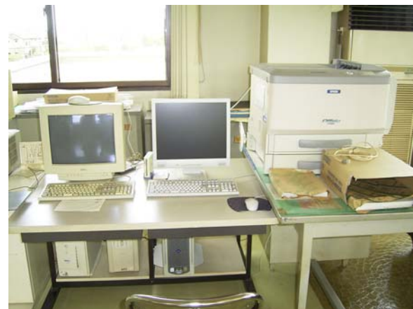
監視室計装機器
