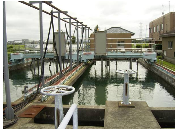
第2薬品沈殿池近景
