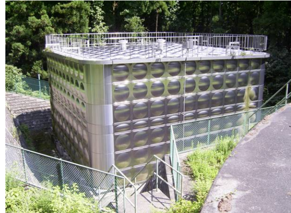
高区ステンレス配水池
