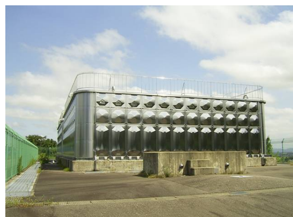
低区ステンレス配水池
