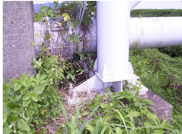
矢川水管橋左岸橋台部
