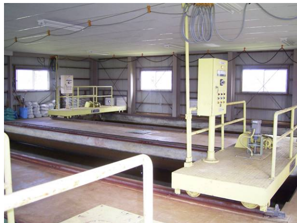
急速ろ過池内部
