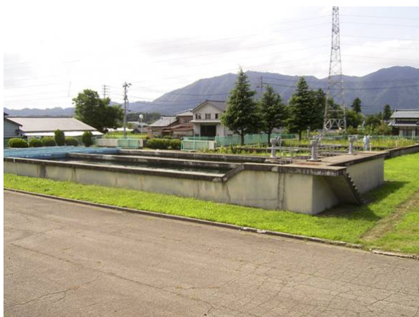
第1薬品沈殿池全景
