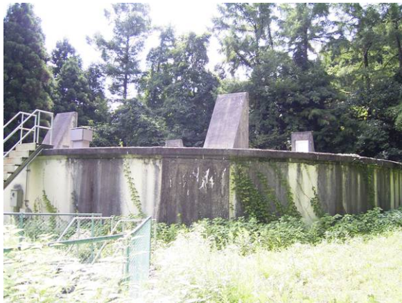
高区PC配水池
