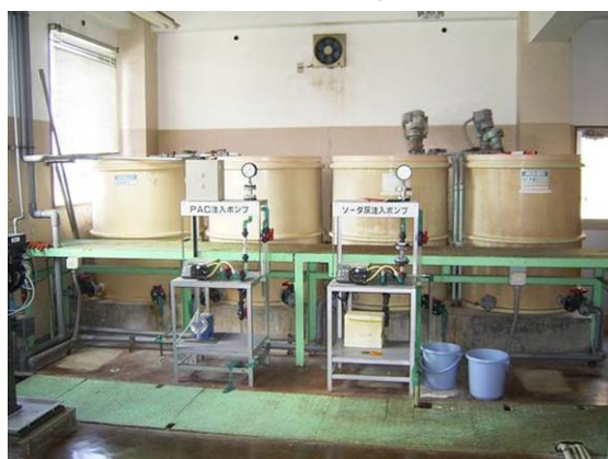
管理棟内部薬注ポンプ
