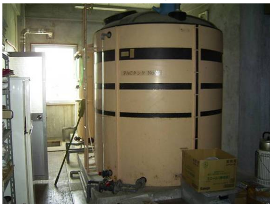
管理棟内部薬液タンク
