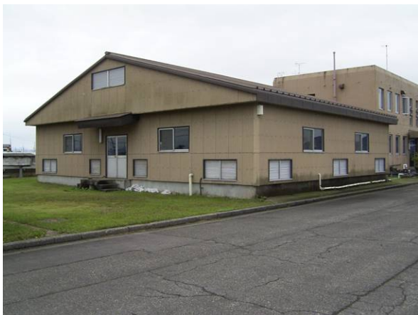
急速ろ過池全景
