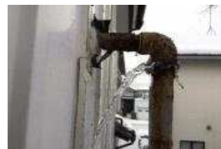
給水管がむき出しになっている
